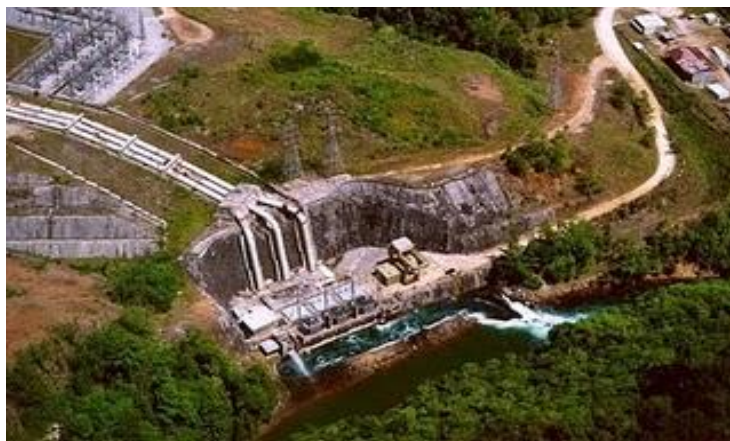
Gambar 3: Penstock dan lokasi turbin PLTA Larona
