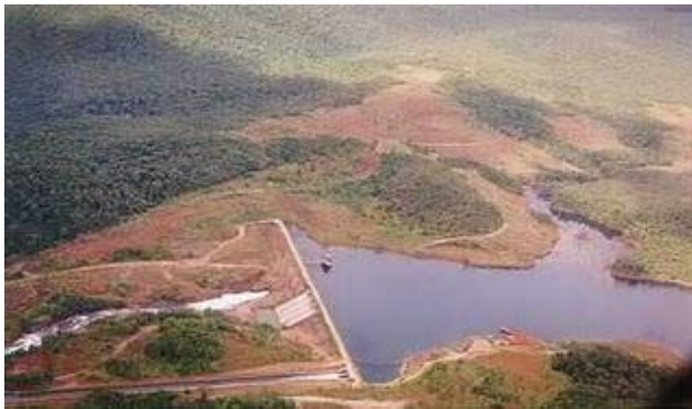
Gambar 2: Bendungan Batu Besi dan kanal terbuka
